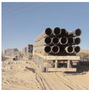
▲ Arribo de la tubería a la obra.
