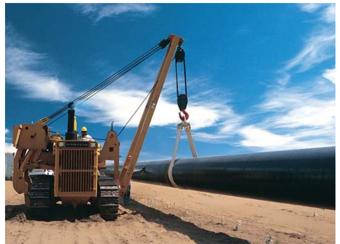
▲ El tiende tubos en plena tarea de desfilado.
