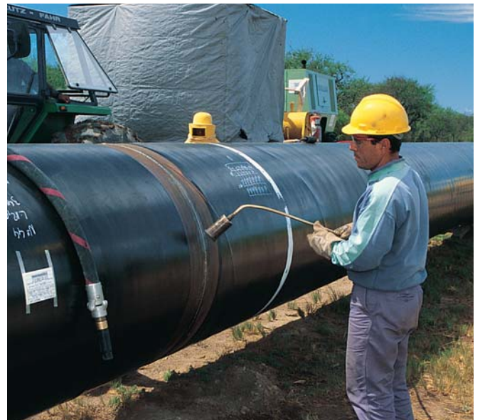
▲ Colocación de las mantas termocontraíbles en tubo de 40" de diámetro.
